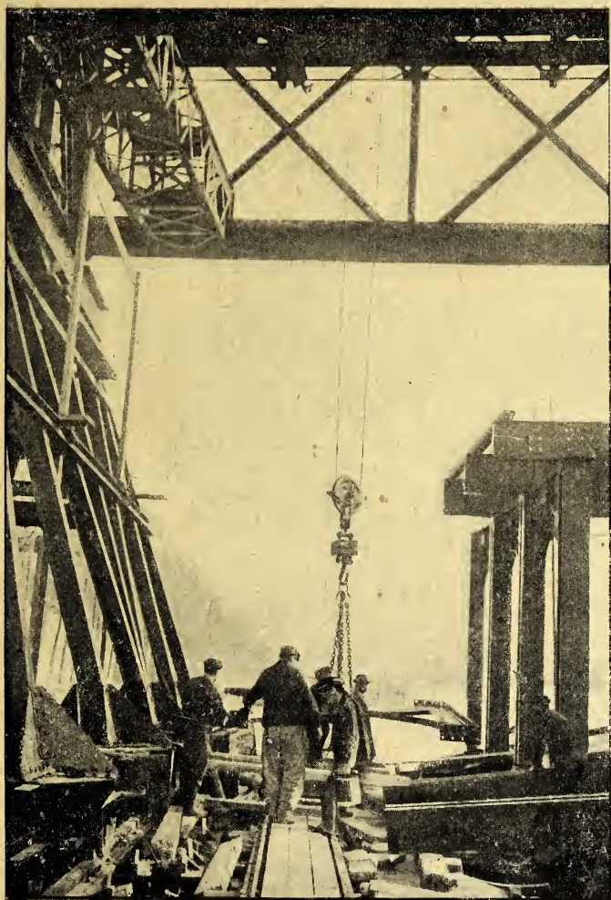
PONT ALEXANDRE III. — MANOEUVRE D'UNE GROSSE PIÈCE DE L'OSSATURE DU PONT (15 février 1899).
